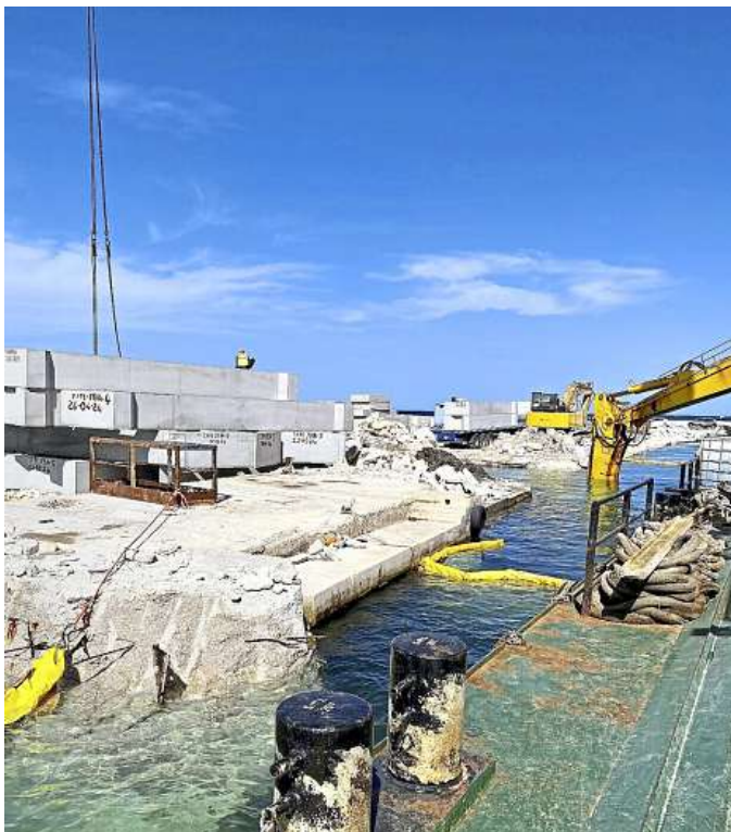
Baustelle auf Malta direkt am Mittelmeer.
